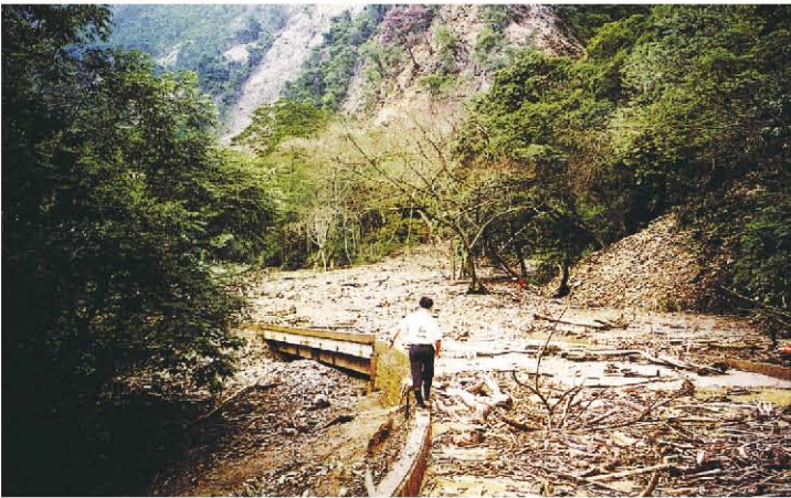
九二一惠蓀林場一號橋震前及震後狀況 照片來源／本校林管處「九二一震後重建史」
