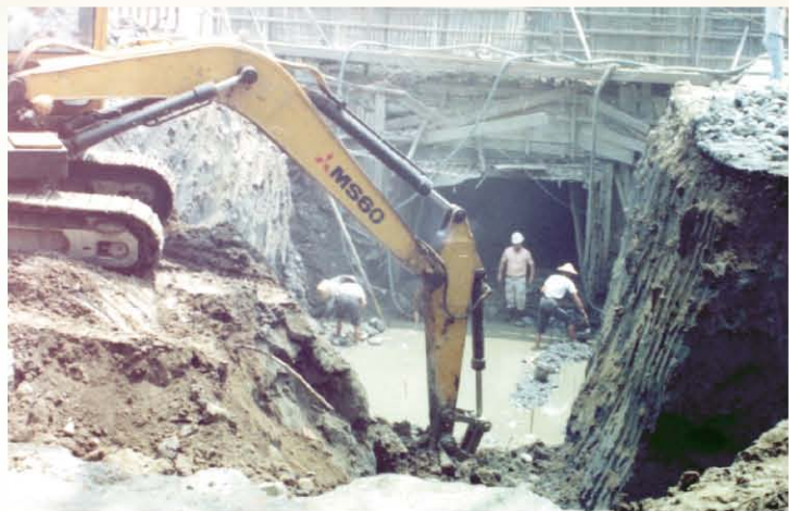
忠明南路中興大學段地下化開挖情形 照片來源／本校校史館
