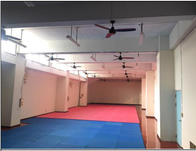
說明：多功能教室吊扇工程
