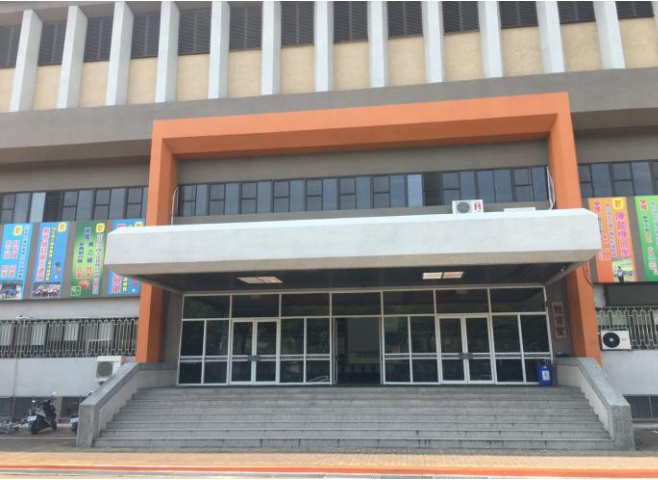
說明：體育館大門門面整修工程
