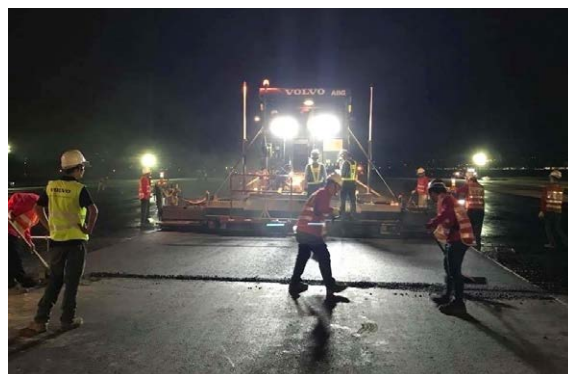
1 民國107年高雄國際機場主跑道整建：瀝青混凝土SMA-徠卡3D鋪面
