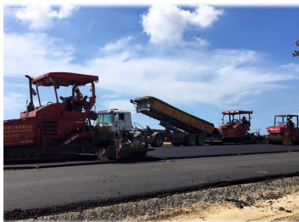
機場鋪面施工
